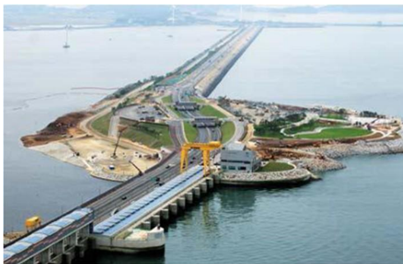
Figura 5 – Usina Maremotriz de Sihwa Lake, em Ansan, Coreia do Sul [3]
