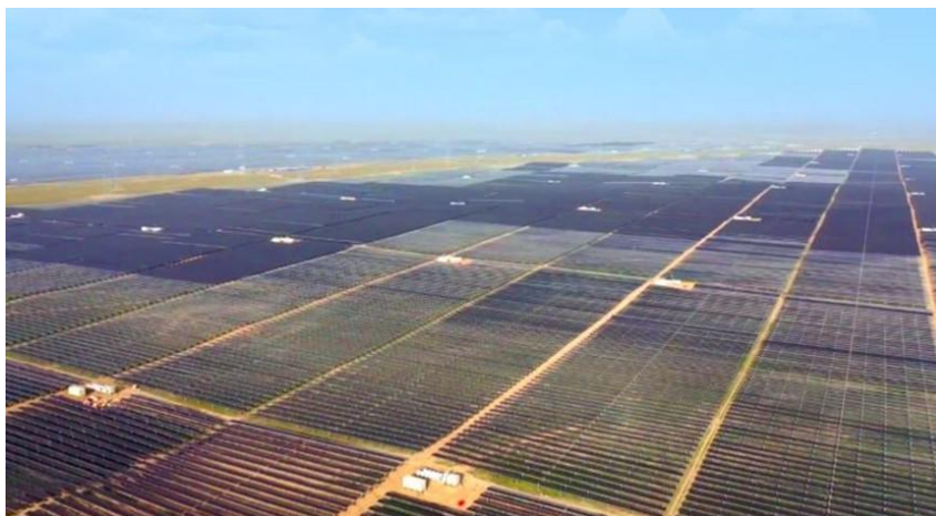
Figura 6 – Vista aérea do complexo fotovoltaico Tengger Desert Solar Park, na China [5]
