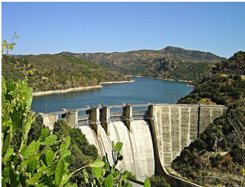
Figura 1 – Aproveitamento Hidroelétrico de Bemposta [1]
