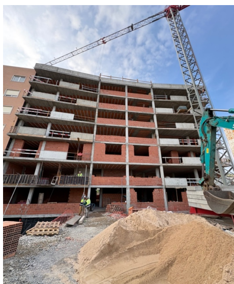
Figura 11: Construção em Betão Armado e Alvenaria de Enchimento nas paredes
