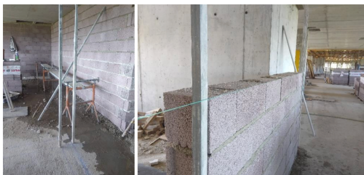
Figura 28: Execução da Alvenaria
