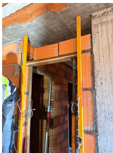
Figura 23: Execução de Verga
