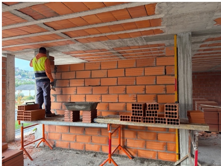
Figura 20: Acompanhamento da Execução
