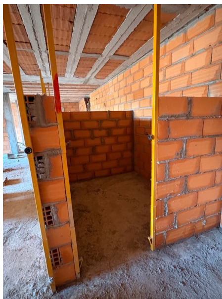
Figura 27: Checagem de Prumo In Loco
