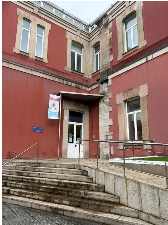
Figura 70- Vista detalle oblicua de la entrada principal del CITENI. Fuente: Elaboración propia.
