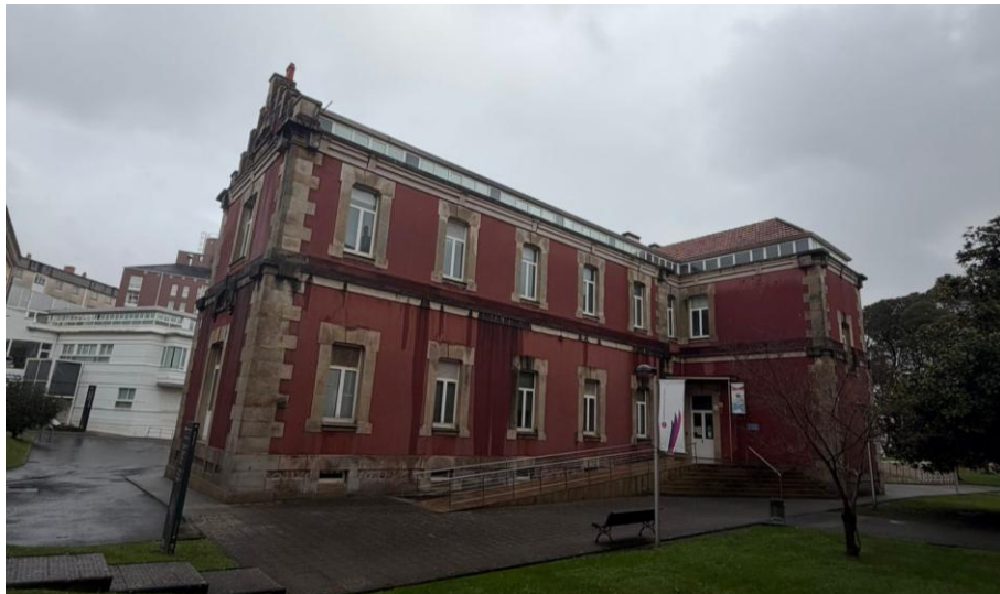
Figura 69- Vista exterior oblicua noreste del CITENI. Fuente: Elaboración propia.
