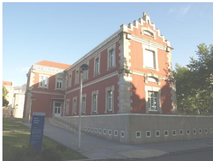
Figura 1- Vista oblicua del edificio CITENI. Fuente: Documentación técnica del edificio.
