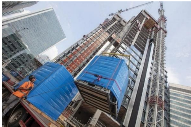
Figura 33: Instalação de módulos sanitários volumétricos em edifício de grande altura.
