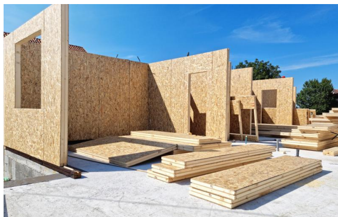
Figura 1: Sistema construtivo em painéis do tipo Wood Frame . Fonte: Casas Alea (2023)
