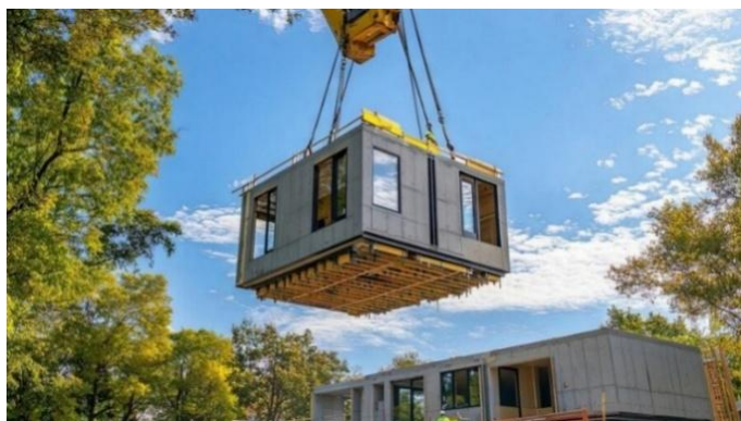
Figura 3: Instalação de módulo volumétrico pré-fabricado em construção modular
