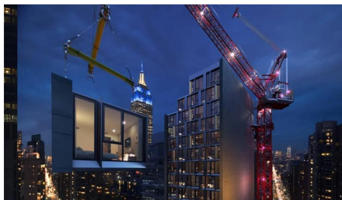
Figura 21: Ilustração da Construção do Marriott AC Hotel em Nova Iorque Fonte: Bloomberg (2019)
