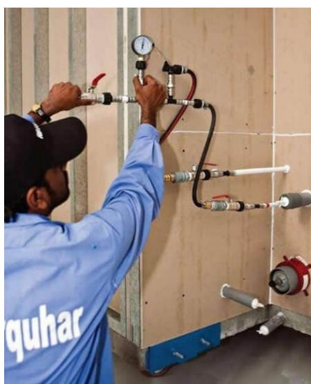
Figura 23: Ensaio de pressão e verificação hidráulica em módulo sanitário industrializado
