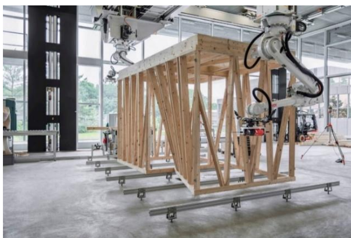
Figura 11: Instalação de módulos volumétricos em sistema construtivo industrializado
