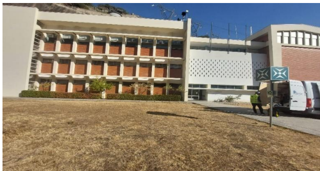
Figura 1 - Edifício da central de Picote.
