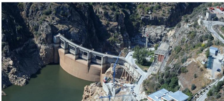
Figura 2 - Albufeira da Central Hidroelétrica de Picote [2].
