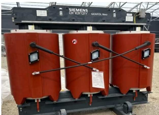
Figura 22 - Transformador de excitação [22].
