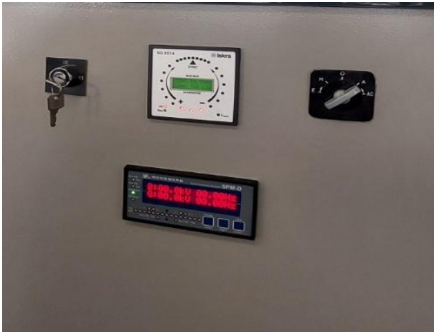
Figura 21 - Sincronizador
