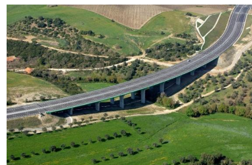
Figura 19 - Viaduto de S. Sebastião. Fonte: Teixeira Duarte Construção.
