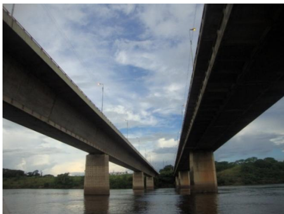
Figura 33 - Ponte sobre o Rio Caroni, Venezuela. Fonte: Piqueras (2015).
