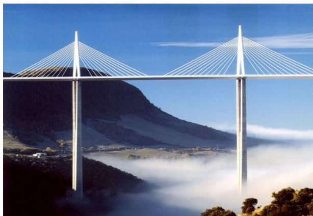
Figura 35 - Viaduto Millau, França. Fonte: TEKHTON ENGENHARIA.
