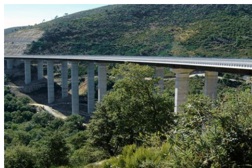
Figura 17 - Viaduto IX. Fonte: Armando Rito Engenharia.
