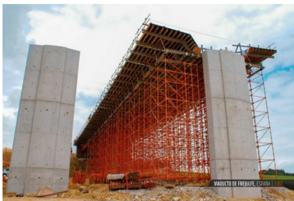
Figura 6 - Estrutura de Cimbramento utilizada para execução de tabuleiro de ponte. Fonte: ConstruGomes.
