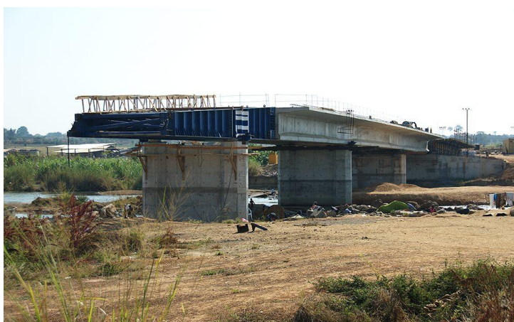
Figura 25 - Nariz metálico na construção da Ponte sobre Rio Cubal da Hanha. Fonte: Armando Rito Engenharia (2009).
