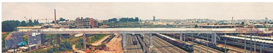
Figura 14 - Passarela para pedestres sobre Ferrovia da FEPASA.
