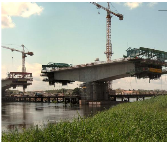
Figura 10 - Método dos Avanços Sucessivos sobre o Rio Kwanza, em Angola. Fonte: ARMANDO RITO ENGENHARIA.
