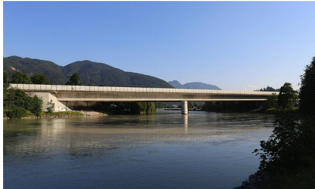
Figura 34 - Ponte Wildbichler sobre o rio Inn, Áustria. Fonte: RUFUS46 (2025).
