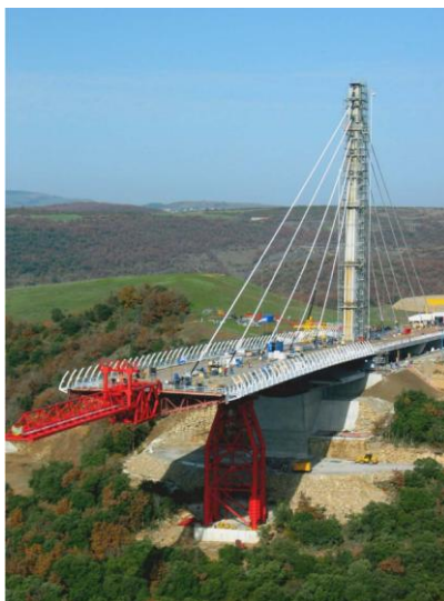
Figura 20 - Avanço do tabuleiro pelo MLI do Viaduto Millau, na França. Fonte: Martin et al. (2004).
